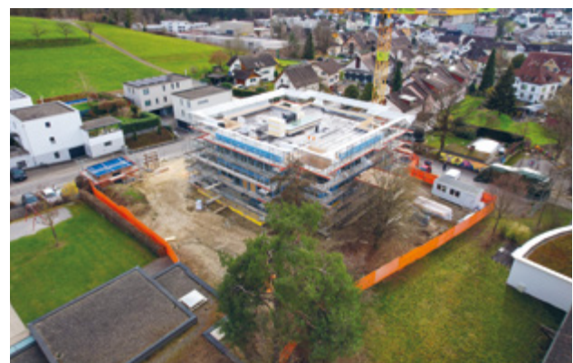
Neubau unterer Dammbühl
